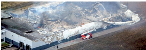
Explosion Ghislenghien : 24 morts, 120 grands brûlés, suite à l'accrochage d'une canalisation de gaz par une pelle mécanique.
