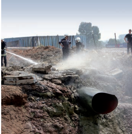
Explosion Ghislenghien : 24 morts, 120 grands brûlés, suite à l'accrochage d'une canalisation de gaz par une pelle mécanique.
